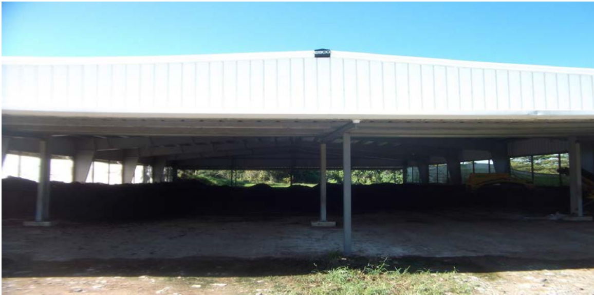
Construcción de viseras
