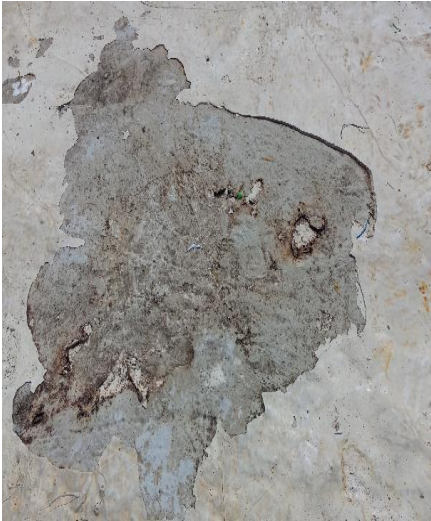
Sellado de techo deteriorado
