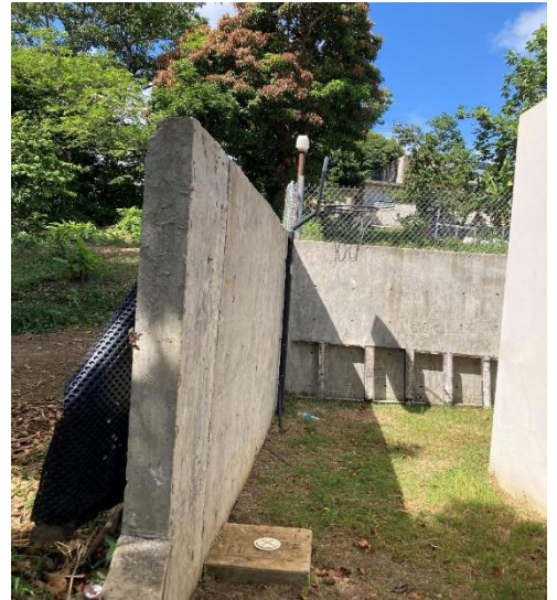
Parte del muro de contención ubicado en el terreno de otra propiedad
